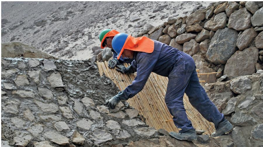
Restitución encañado y cubierta de piedra de la qolqa, 2019
