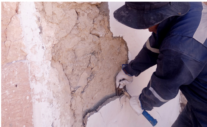
Imagen N°8 y 9 Proceso de conservación y restauración de la Capilla San Isidro de Quipisca. Fotografía de Juan Carlos Caveró Catalán, año 2023.
