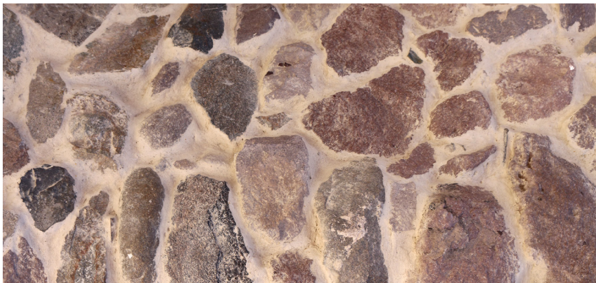
Imagen N°10: Detalle muro campanario. Fotografía de Constanza Cáceres, año 2025.
